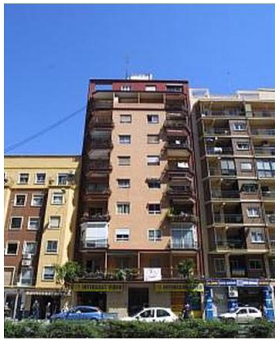
Fotografía de la fachada principal
