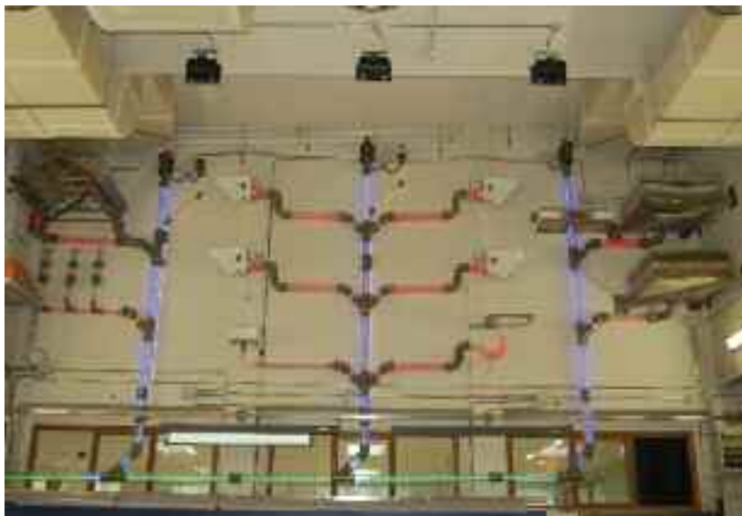
Simuladores de fontanería y saneamiento y de baño completo con suelo radiante
