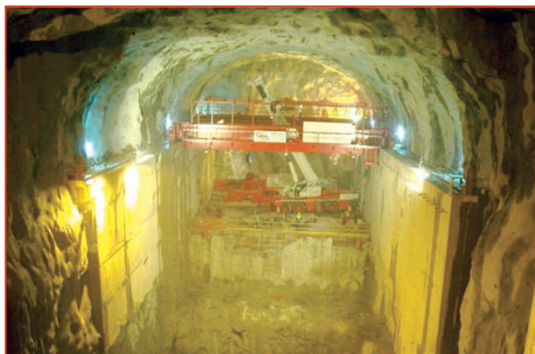
■ [Foto 10].- Vista de la ejecución de la caverna de la central.
