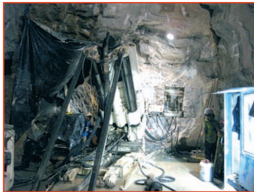
[Foto 6] .- Vista del equipo de raise boring para ejecución del tramo inclinado de la conducción forzada.
