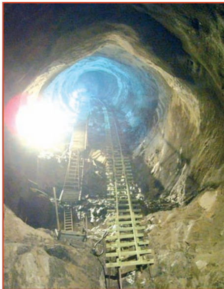
[Figura 8].- Sistema de ejecución del codo en el tramo inclinado de la conducción forzada.
