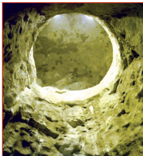
■ [Foto 9].- Diámetro final del pozo.
