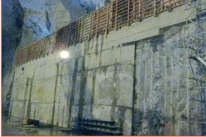
■ [Foto 13].- Hormigón encofrado para evitar las cuñas de terreno.
