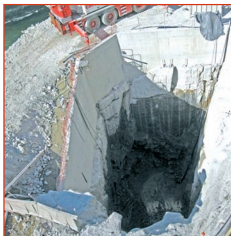
■ [Foto 4].- Ejecución del pozo en cauce seco.
