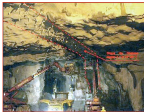
■ [Foto 12].- Saneado, bulonado y gunitado del dique para refuerzo del sostenimiento.
