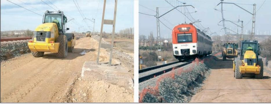
[Figura 12].- Equipo de compactación normal utilizado para acabado de capas de asiento: capa de forma y sub-balasto.
