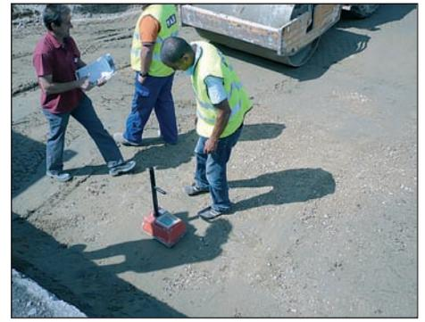
[Figura 14].- Control de la compactación del sub-balasto mediante medidas nucleares de la densidad seca y humedad.
