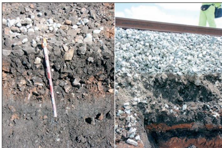
[Figura 10].- Capa de "carbonilla" interpuesta entre la plataforma y el balasto. De esta manera se conseguía en las antiguas líneas convencionales evitar las filtraciones a la plataforma.
