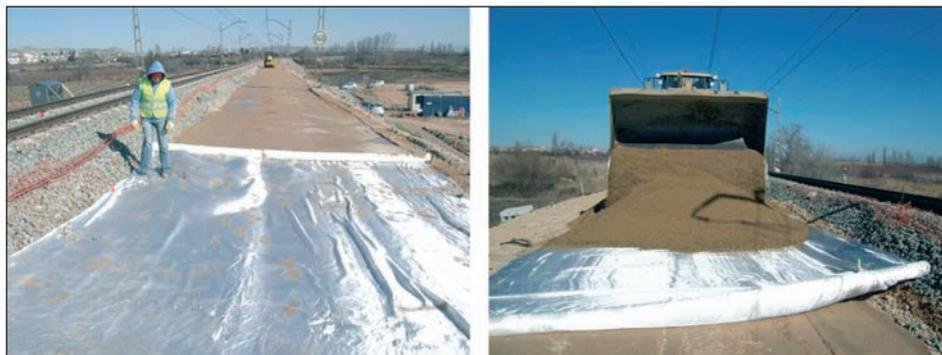
[Figura 11].- Colocación de Geotextil de alto módulo de elasticidad sobre el que se vierte el *sub-balasto* para su posterior compactación. A parte de impermeabilizar el contacto del *sub-balasto* con la plataforma, facilitando el drenaje hacia las canaletas exteriores, este material tiene alta resistencia al punzonamiento por lo que mejora el comportamiento del *sub-balasto* ante posibles asentamientos de la capa de formador.
