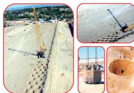
[Fig. 2] .- Compactación dinámica en las Cocheras del metro ligero en Madrid.
