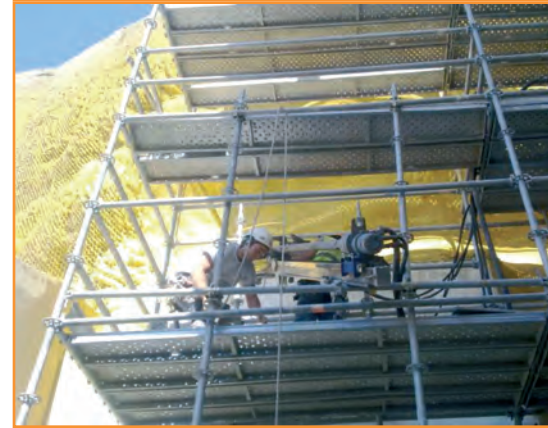
[Fotos 6 y 7].- Vistas de la máquina de perforación fijada al andamio.
