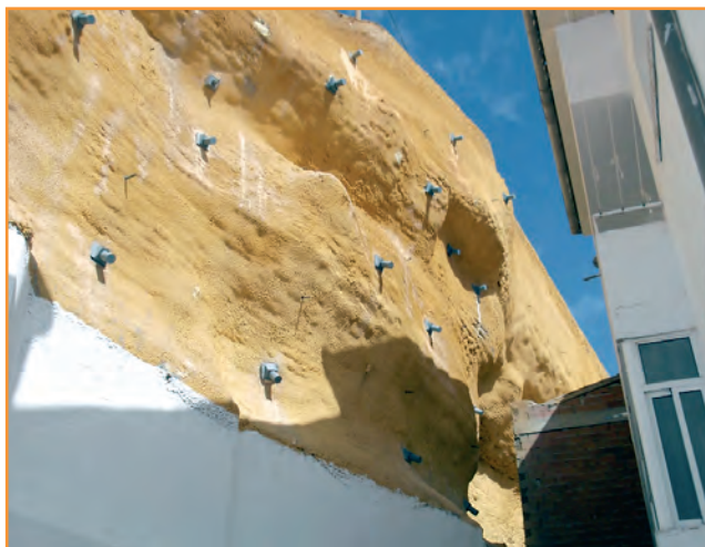
■ [Foto 8].- Disposición de anclajes y gunita pigmentada.
