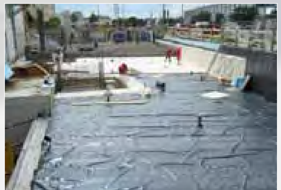
Armado de losa base
