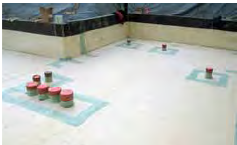
Detalle de una junta interna terminada
