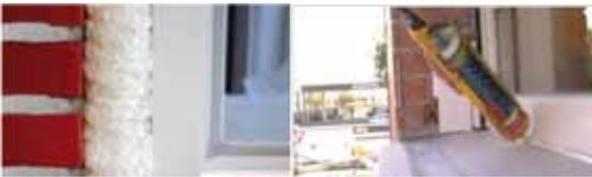
▲ Anclaje mecánico de la carpintería al hueco, sellado de aislamiento con espuma PU y sellado perimetral entre carpintería
