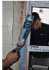
**Fijación de las membranas:** las membranas portan unas bandas autoadhesivas que permiten la fijación directa sobre la carpintería y la mampostería, no obstante, es recomendable asegurar su fijación mediante un adhesivo transpirable mientras se ejecuta la terminación del resto de la obra.
