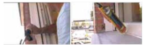
mediante el uso de tornillería adecuada. Nunca debe usarse la espuma PU para la fijación única de la ventana. El puente térmico provocado por el tornillo se elimina con tacos específicos.
