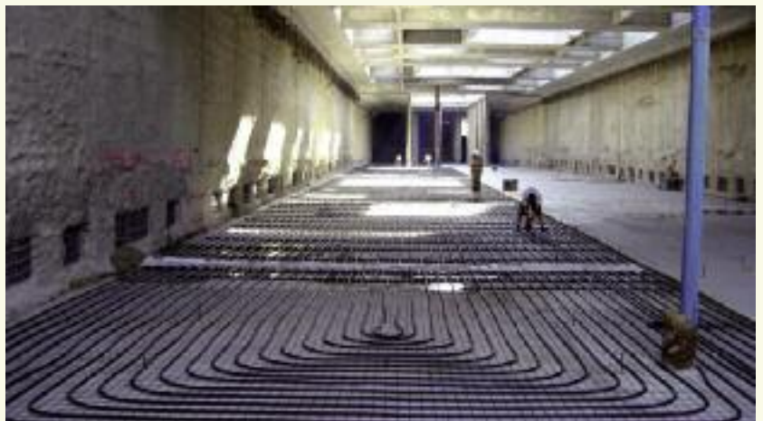
Ejecución de un tramo de losa termoactiva, sistema ENERCRET. ENERES - ENERCRET
