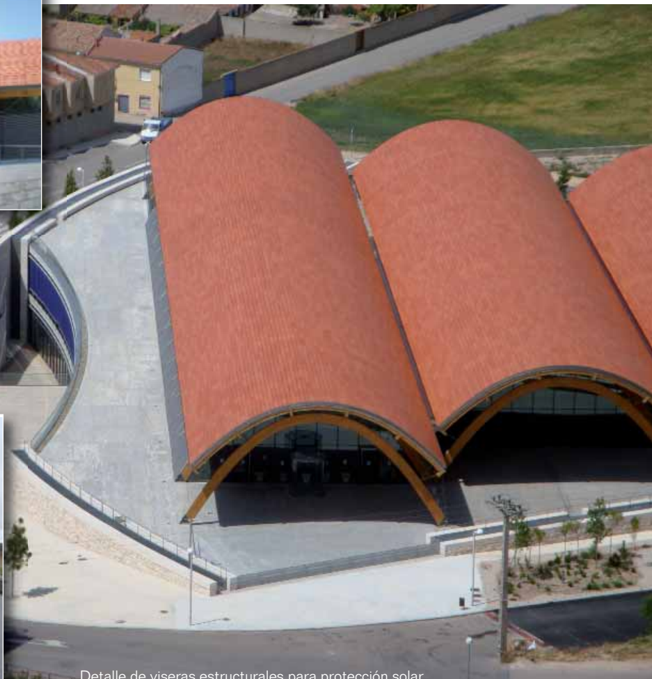
Detalle de viseras estructurales para protección solar
