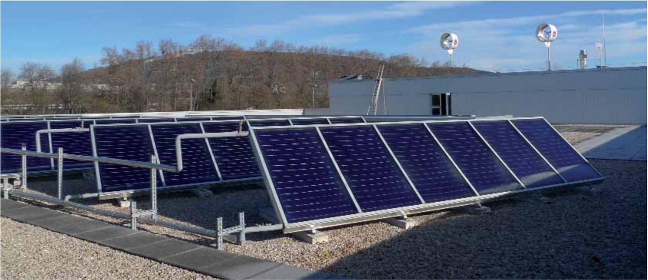
Instalación solar térmica para la producción de ACS y calentamiento de piscina.
