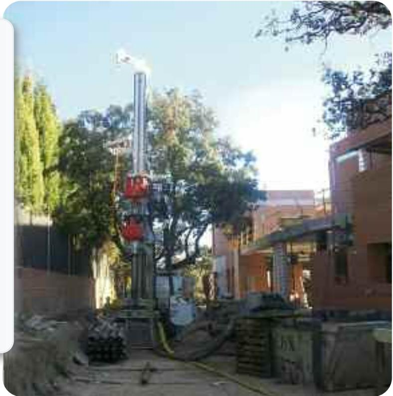
El sistema funciona intercambiando calor con el subsuelo. Esas perforaciones conectadas componen un sistema de tuberías en circuito cerrado que permiten este intercambio al estar enterradas en los sondeos realizados previamente. Por ellas circula agua con un líquido anticongelante. Para evitar la posible interconexión entre los diferentes acuíferos y la contaminación de los mismos, las perforaciones se rellenaron con mortero termoconductor, aislándolas completamente.
