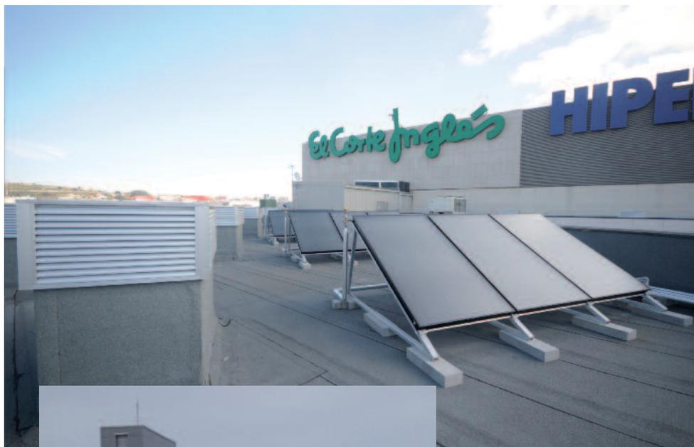
La instalación de producción de ACS tiene una cobertura solar del 32,5% y la calificación energética en ACS es A
