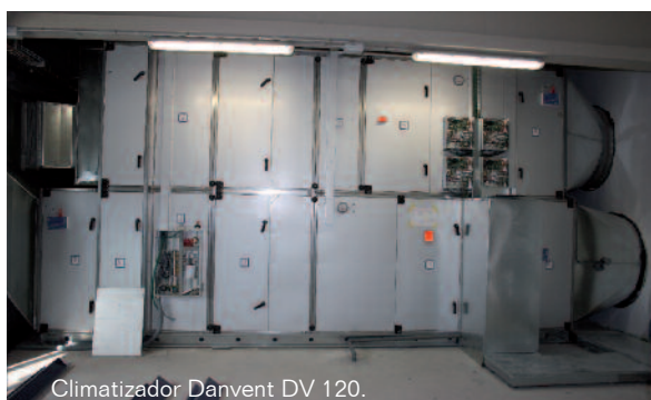
Instalación de climatización Novomatic.
