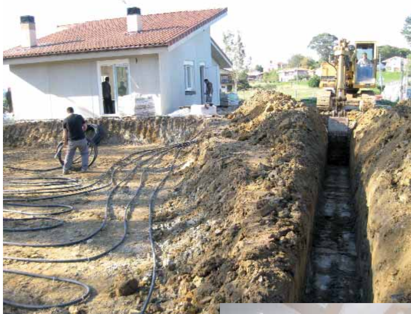
Colocación de captación horizontal y zanja del pozo canadiense-provenzal
