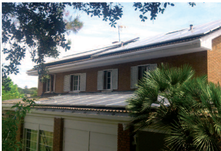
Instalación de los paneles solares en la vivienda.
