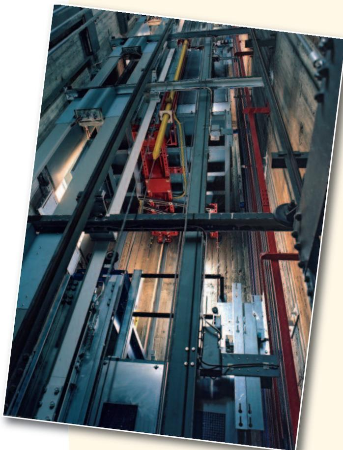
Al Sultan Tower es un edificio de unos 75 metros de altura, situado en el centro de Doha, y que fue inaugurado en 1976. Ahora, con la renovación del edificio, ThyssenKrupp Elevator sustituirá los actuales ascensores por dos flexibles, rápidos y cómodos sistemas TWIN con cuatro cabinas.
