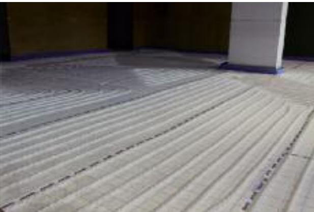
Instalación de suelo radiante en parte de la planta baja y planta primera
