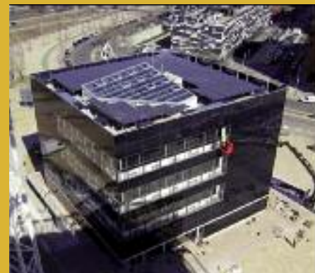
Cubierta y fachada sur
