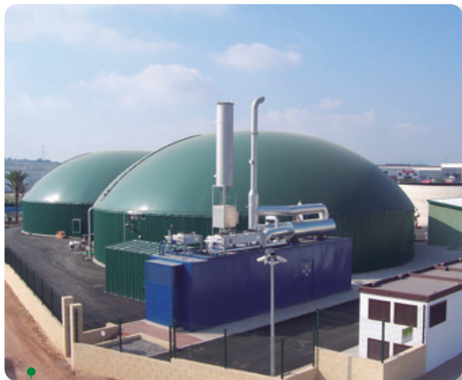
Planta de biogás Vall d'Uixó (Castellón). Fuente Biovic Biogas plant Vall d'Uixó (Castellón). Source: Biovic
