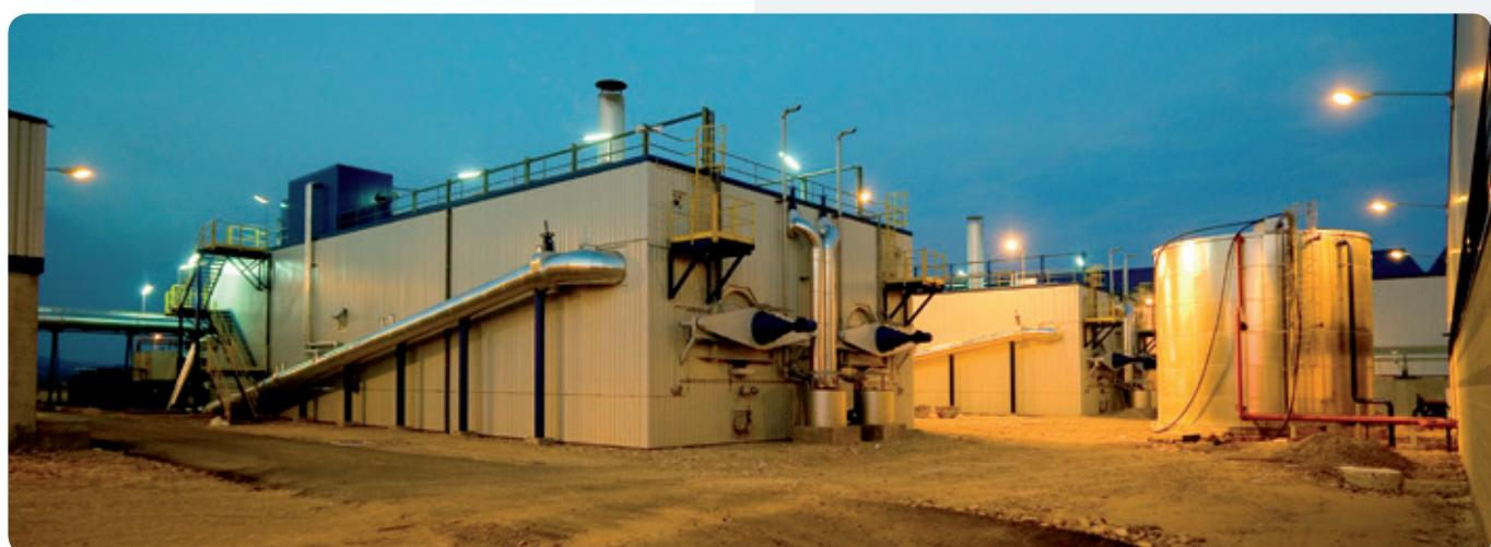
a un proceso de compostaje, almacenamiento y afino y da lugar, por un lado, a material bioestabilizado y por otro, a un rechazo de pequeños improprios que se destina a vertedero.
