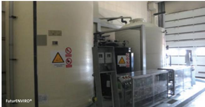
Por otra parte, se ha instalado un equipo de preparación en continuo de polielectrolito de capacidad 850 l/h en el espacio libre entre el desarenado – desengrasado y las cámaras de mezcla y floculación. De este equipo aspiran las tres (2+1) bombas dosificadoras helicoidales accionadas mediante variadores de frecuencia, con un rango de caudal unitario entre 100 y 300 l/h, reguladas según el caudal a tratar.
