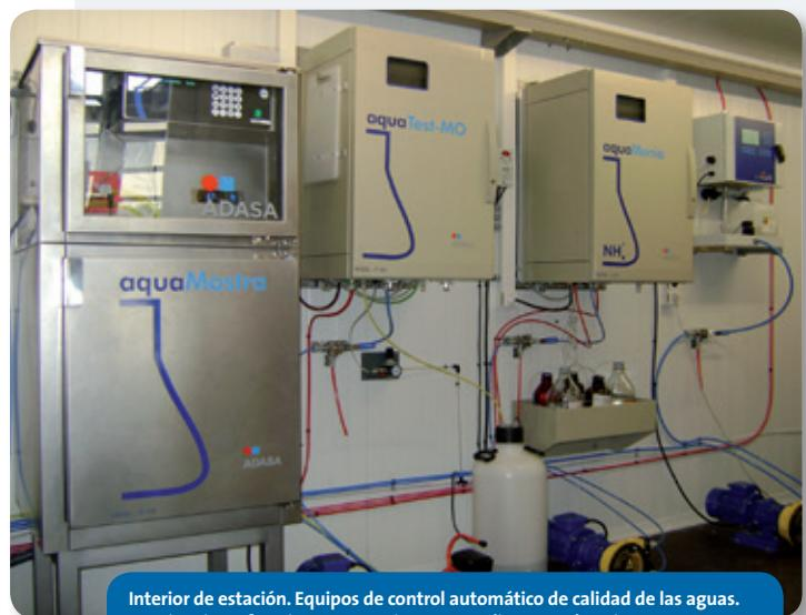
Interior de estación. Equipos de control automático de calidad de las aguas.
