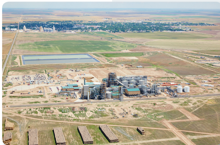
Planta de bioetanol celulósico que Abengoa tiene en Hugoton, Kansas (EE. UU.). Abengoa cellulosic bioethanol plant in Hugoton, Kansas (USA).
