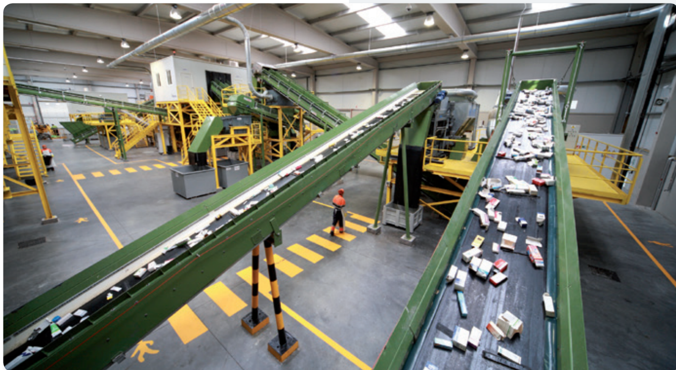
Interior de la Planta de Tratamiento de Envases y Residuos de Medicamentos ubicada en Tudela de Duero (Valladolid) | Interior of the Pharmaceutical Packaging and Waste Treatment Plant located in Tudela de Duero (Valladolid)
