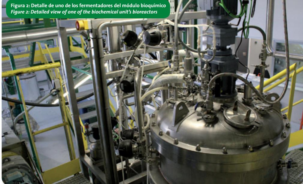
**Figura 2: Detalle de uno de los fermentadores del módulo bioquímico**
