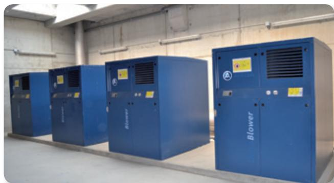
Se instalan 4 soplantes de émbolos rotativos (una en reserva) de  $2.129 \text{ Sm}^3/\text{h}$  de caudal unitario a 6 mca, cada una de ellas con un motor de 55 kW., reguladas por variador de frecuencia, e insonorizadas mediante su correspondiente cabina de insonorización.
