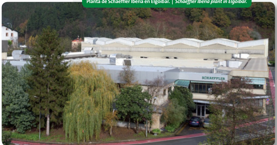
Planta de Schaeffler Iberia en Elgoibar. | Schaeffler Iberia plant in Elgoibar.
