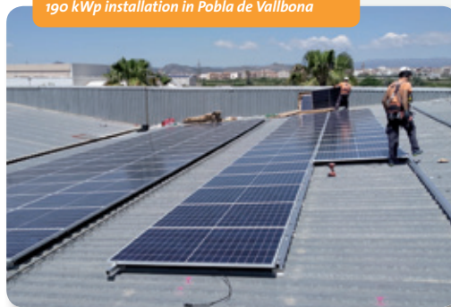
Instalación de 190 kWp en Poble de Vallbona 190 kWp installation in Poble de Vallbona
