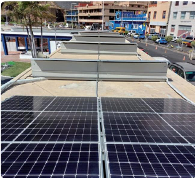
estructura importada de Italia, el sistema Vela de Sun Ballast. Se trata de un sistema de hormigón apto para suelos planos que cumple la función tanto de estructura de soporte como de contrapeso del módulo fotovoltaico.
