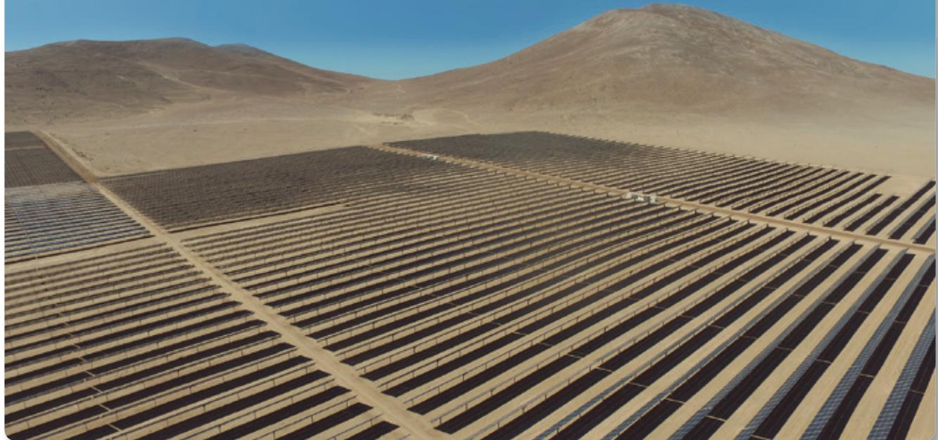
entornos. Además, SFOne tiene una configuración a un solo eje de doble fila y está diseñado para módulos de 72 a 78 células. El seguidor aporta una mayor facilidad de instalación, lo que hace más rápido el proceso de construcción de la planta.
