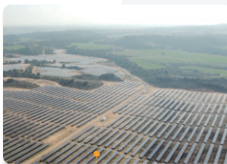
Planta fotovoltaica Desafío Solar de Falck Renewables, en Escatrón (Zaragoza) The Falck Renewables Desafío Solar PV plant in Escatrón (Zaragoza).
