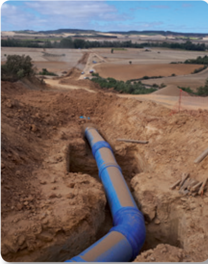
Instalación de Tuberías TOM® de PVC Orientado | Installation of TOM® Oriented PVC pipes
