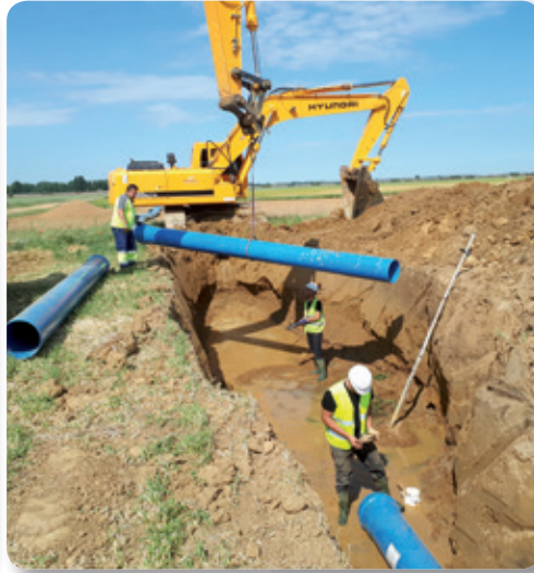
Instalación de Tuberías TOM® de PVC Orientado | Installation of TOM® Oriented PVC pipes
