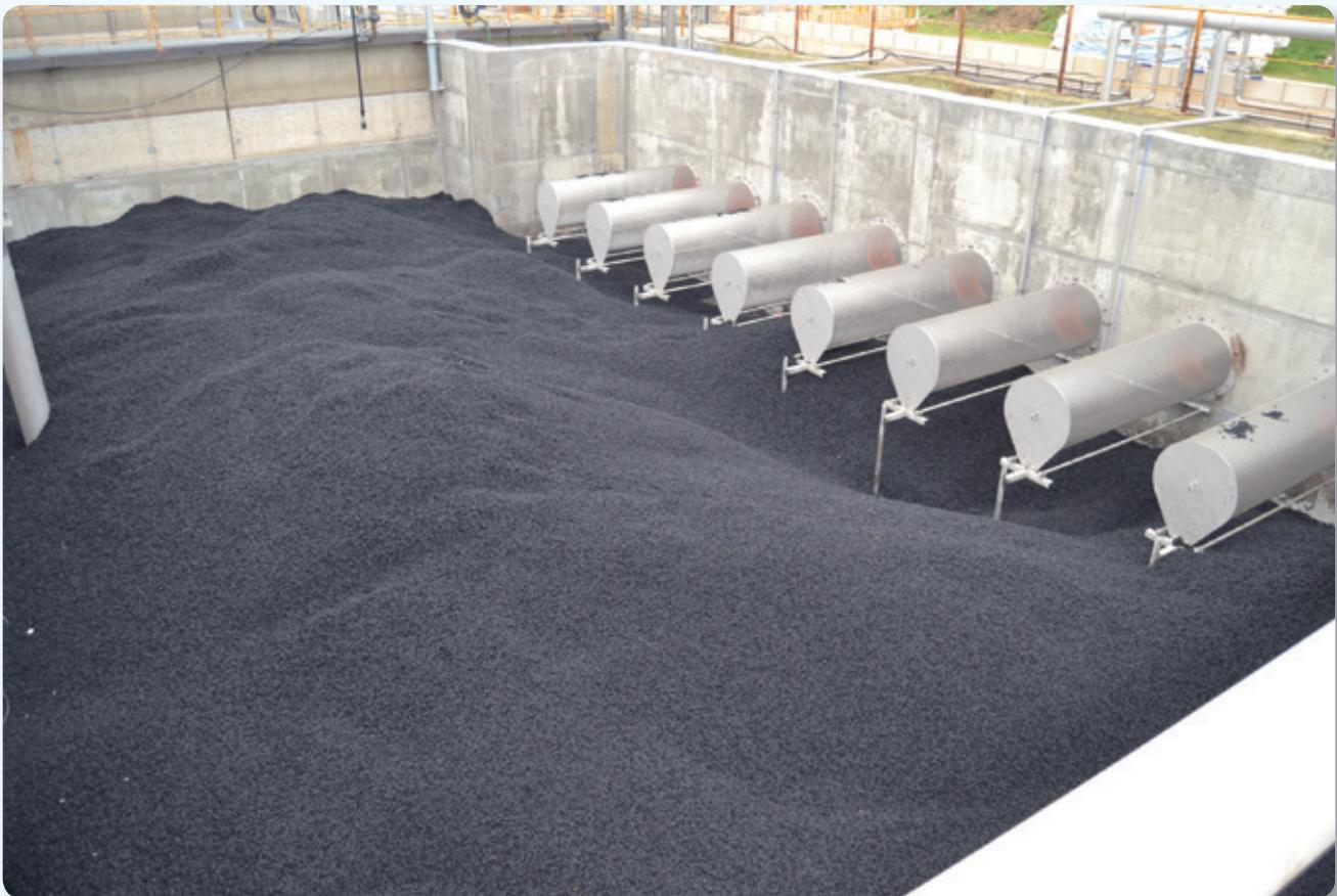
Aqseptence Group con su marca Johnson Screens® ha suministrado para la EDAR de Casaquemada tambores de malla de perfil tipo wedgewire para mantener el material de relleno dentro del proceso biológico y así garantizar el soporte de diseño.
