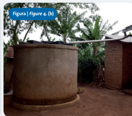
Figura 4. (a) Prototipo de foto-reactor para desinfección solar y potabilización de agua de lluvia, (b) Contenedor de recogida de agua de lluvia ubicado en escuela educación primaria en la zona rural de Makondo, Uganda. | Figure 4. (a) Photo-reactor prototype for rainwater disinfection and potabilisation, (b) Rainwater collection container at primary school in the rural area of Makondo, Uganda.
