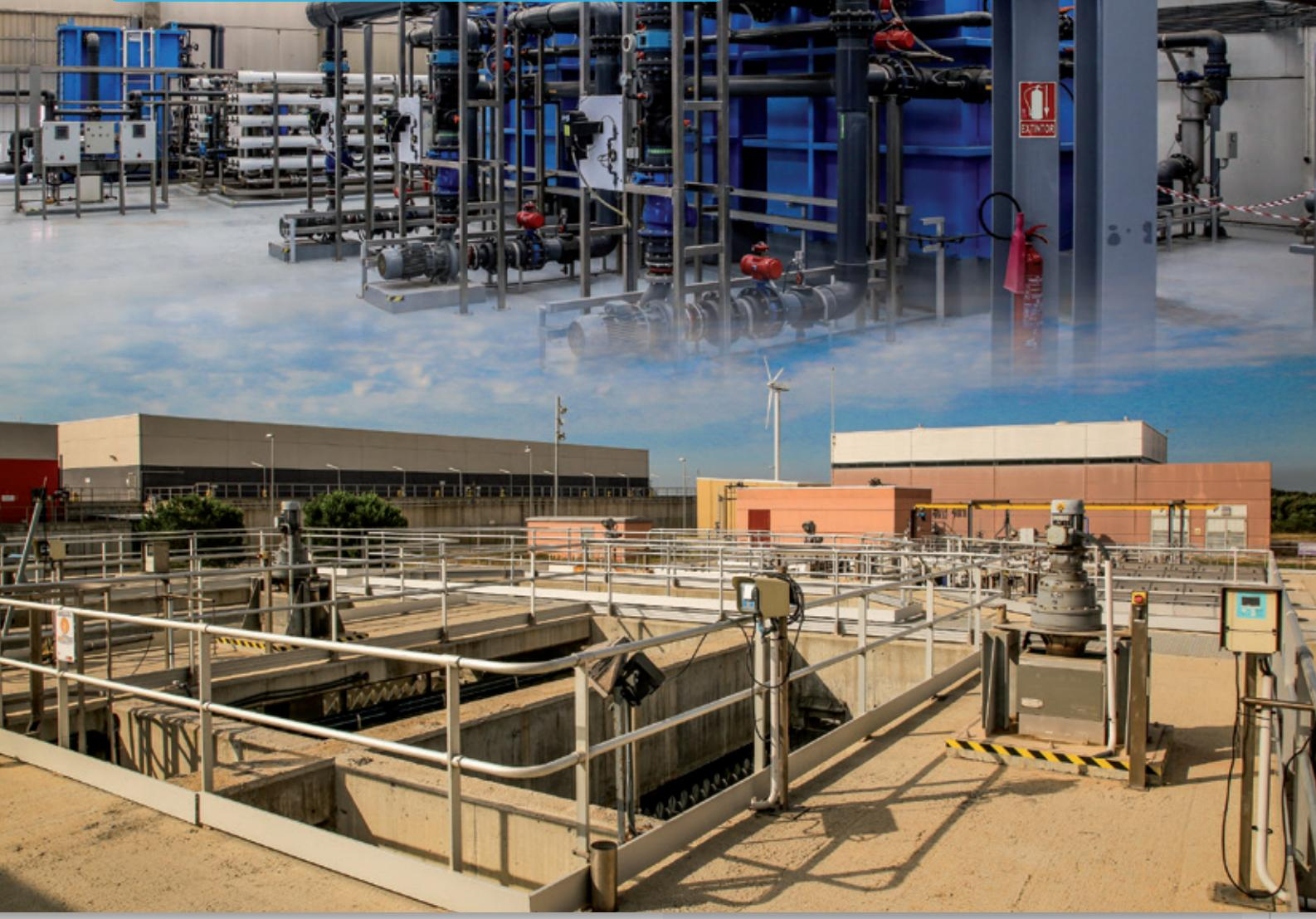
A PRINCIPIOS DE ABRIL, ENTRABA EN FUNCIONAMIENTO LA ESTACIÓN DE REGENERACIÓN DE AGUAS (ERA) DEL PRAT DE LLOBREGAT QUE, POR MEDIO DE UN TRATAMIENTO ESPECIAL DA COMO RESULTADO UN AGUA APTA PARA SER VERTIDA RÍO ARRIBA, EN CASO DE NECESIDAD, POR EJEMPLO ANTE UNA ALERTA POR SEQUÍA. LA PUESTA EN MARCHA DE ESTA INSTALACIÓN ES CLAVE PARA AUMENTAR LA GARANTÍA DE SUMINISTRO EN EL ÁREA METROPOLITANA DE BARCELONA.
