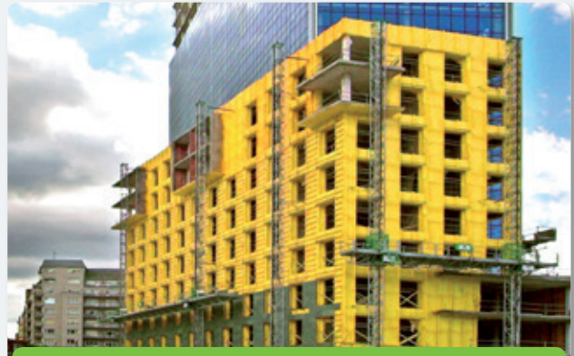
Edificio aislado con PU. Foto cortesía de IPUR | Polyurethane-insulated building. Photo courtesy of IPUR
