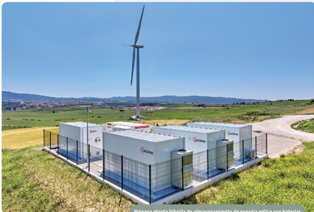
Primera planta híbrida de almacenamiento de energía eólica con baterías en España | First hybrid wind power storage plant in Spain using batteries. Foto cortesía de / Photo courtesy of: Acciona
