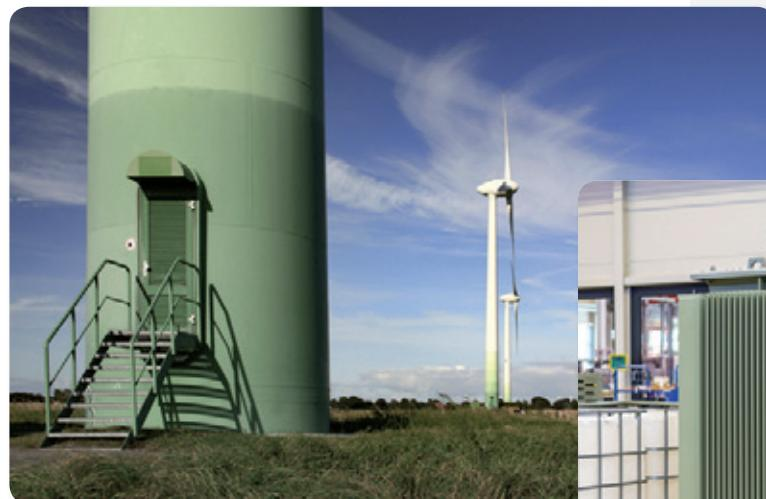
Los cuatro aerogeneradores Enercon E-115, con una potencia nominal unitaria de 3 MW, están diseñados para emplezamientos terrestres con condiciones de poco viento. Los aerogeneradores, con un diámetro de rotor de 115 m, se erigieron sobre torres de hormigón
