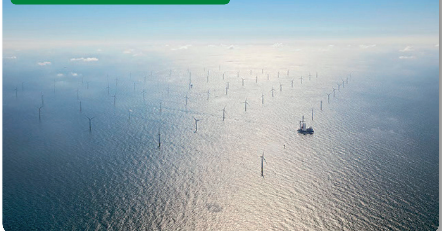
Parque eólico marino Gemini | Gemini offshore wind farm
