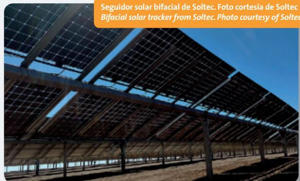
Seguidor solar bifacial de Soltec. Foto cortesía de Soltec
