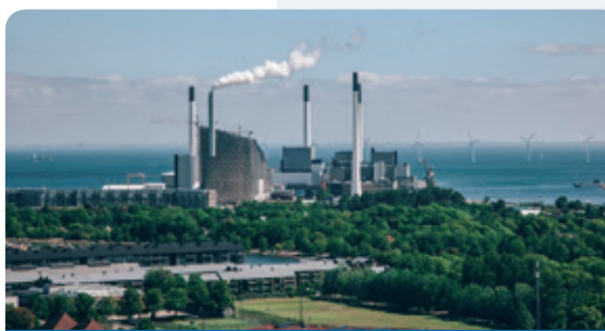
Amager Bakke es una planta de cogeneración en Copenhague que produce electricidad o calor dependiendo de la demanda de calor local y los precios de la electricidad. | Amager Bakke is a combined heating and power plant in Copenhagen that produces either electricity or heat depending on local heat demand and power prices.
