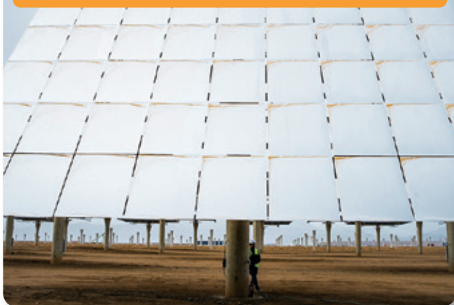
Heliostatos en la planta NOORo III, Ouarzazate, Marruecos. Foto cortesía de Sener Heliostats at the NOORo III, Ouarzazate, Morocco. Photo courtesy of Sener
