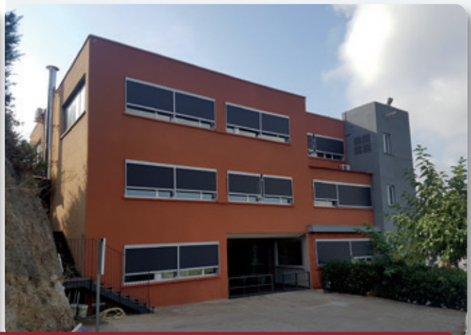
Figura 1. Escola Virolai. Antes y después de la reforma de la fachada integrando control solar automático. | Figure 1. Escola Virolai. Before and after refurbishing the façade to integrate automatic solar control.
