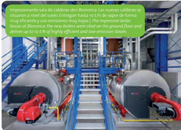
Impresionante sala de calderas den Bionorica. Las nuevas calderas se situaron a nivel del suelo. Entregan hasta 10 t/h de vapor de forma muy eficiente y con emisiones muy bajas | The impressive boiler house at Bionorica: the new boilers were sited on the ground floor and deliver up to 10 t/h of highly efficient and low-emission steam.
