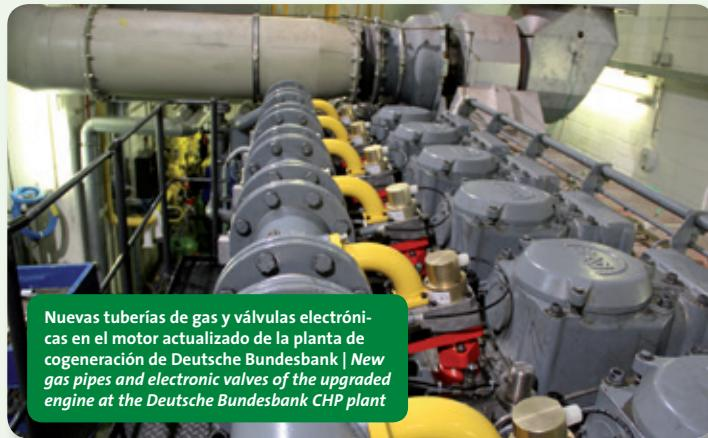
Nuevas tuberías de gas y válvulas electrónicas en el motor actualizado de la planta de cogeneración de Deutsche Bundesbank | New gas pipes and electronic valves of the upgraded engine at the Deutsche Bundesbank CHP plant
