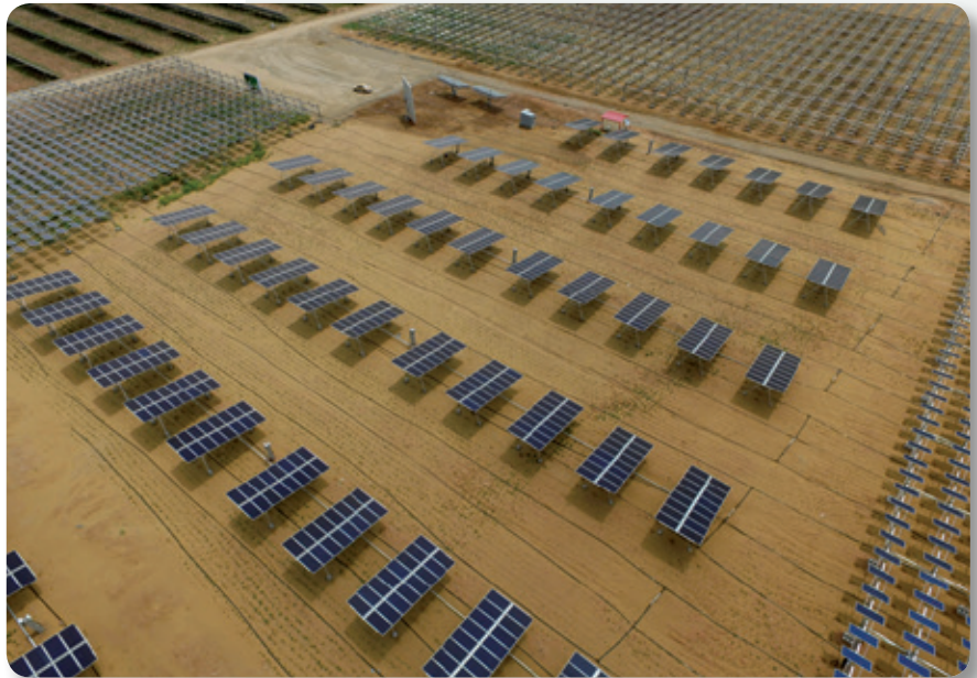
Proyecto Kubuqi, bifacial + seguidor, ganancia energética ~25% | Kubuqi project, bifacial + tracker energy gain ~25%
