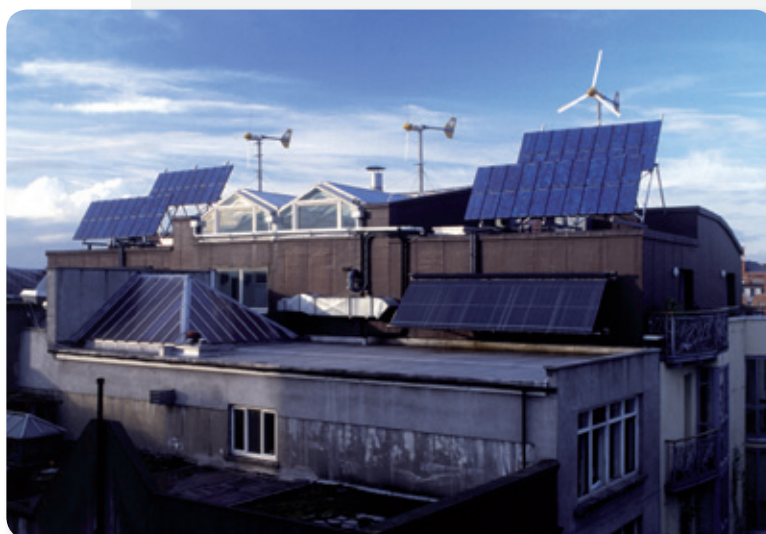
Uso de tecnologías energéticas eficientes en Dublín (Irlanda). El tejado aloja, aerogeneradores, y paneles fotovoltaicos para producción de electricidad, junto con colectores solares térmicos que proporcionan agua caliente al edificio. Foto cortesía: CE- Servicio Audiovisual | Use of energy efficient technologies in Dublin (Ireland). The roof houses wind turbines and PV panels for producing energy together with solar thermal collectors which provide hot water to the building. Photo courtesy: EC-Audiovisual Service
