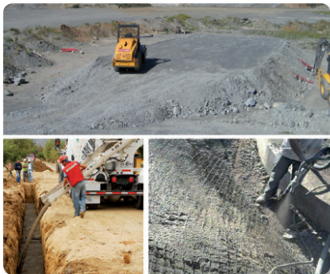
Aplicaciones de construcción previstas para uso de arena regenerada como árido fino secundario en LIFE ECO-SANDFILL: terraplén, MBRC y mortero bombeado Construction applications envisaged for use of reclaimed SFS as secondary fine aggregates in LIFE ECO-SANDFILL: Embankment, CLSM and flowable mortar for spraying
