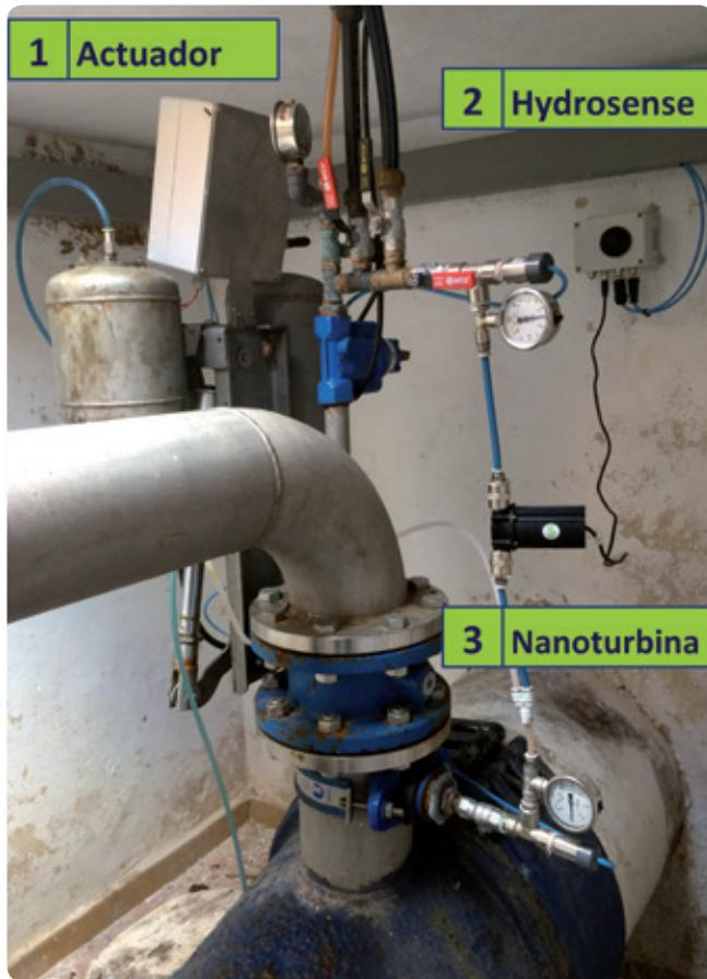
eficiente de la red, aumentando el ratio de eficiencia hidráulica por control de mínimos nocturnos y disminución de fugas.
