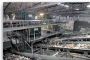
¡PLANTAS COMPLETAS CON TRATAMIENTO GALVANIZADO! COMPLETE PLANTS WITH GALVANIZED TREATMENT
